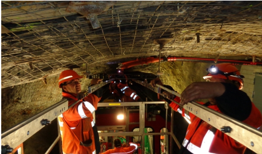
Mitarbeitende des Technischen Unterhalts beim Einsatz im Tunnel der Jungfraubahn
