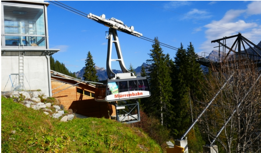
Die Luftseilbahn der BLM kurz vor der Ankunft auf Grütschalp
