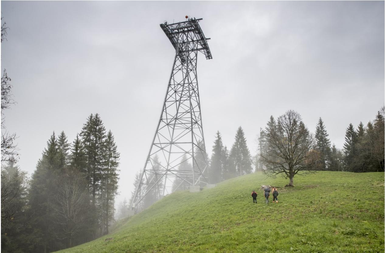
*Beim Aushub Mastenbau wurden Unter- und Oberboden rekultiviert. Die Weide wurde mit entsprechenden Saatgut in den Ursprungszustand versetzt. Der Boden braucht 2 Jahre, bis er wieder stabil ist. Teils kann mit Schafen für kurze Zeit geweidet werden.*
