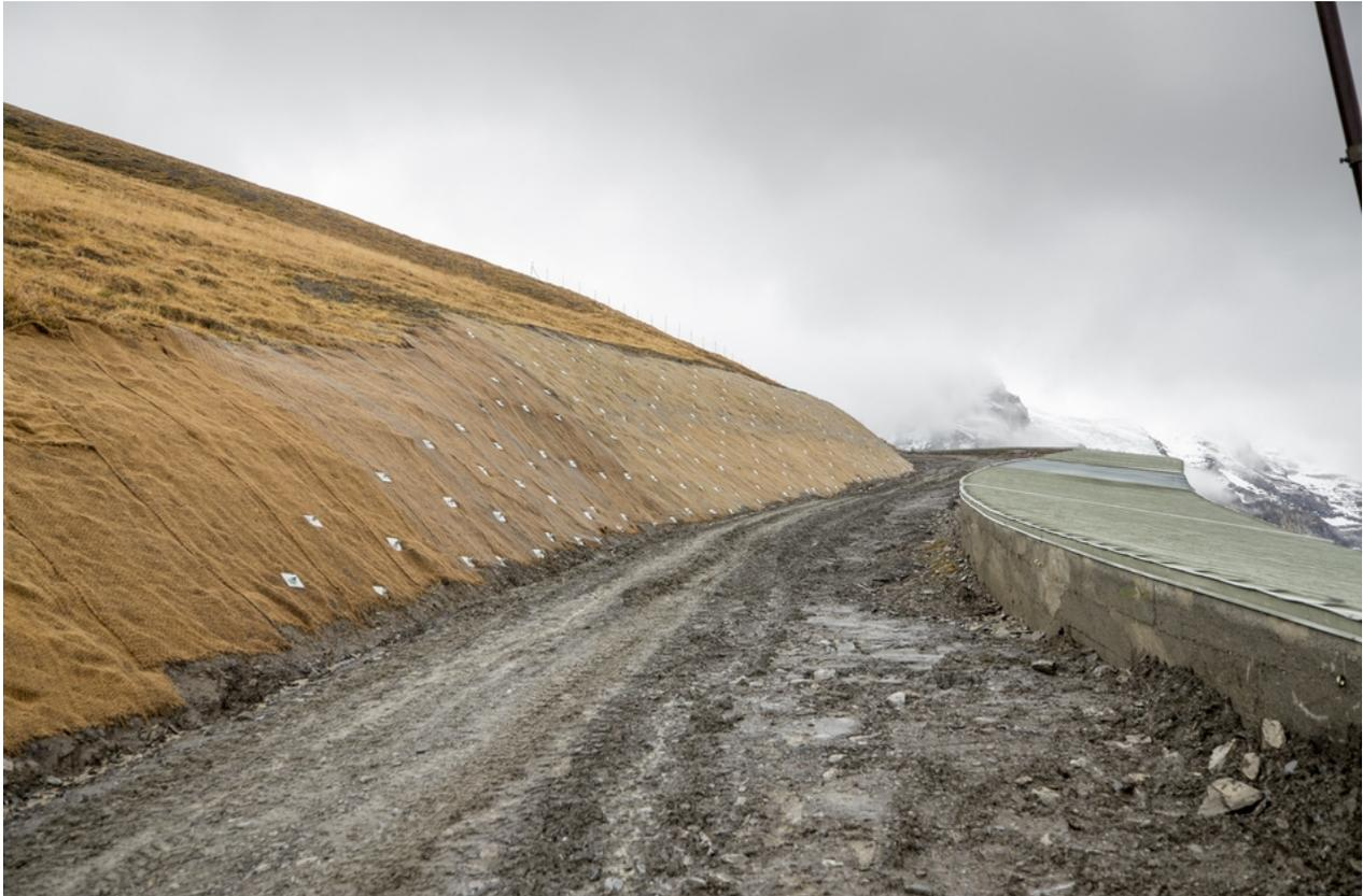
*Jungfraubahn-Galerie und blaue Piste. Die Böschung wird mit Jutenetzen und Ankern befestigt. Zuerst werden die Mutten angebracht, dann das Netz, das mit der Zeit überwachsen wird.*
