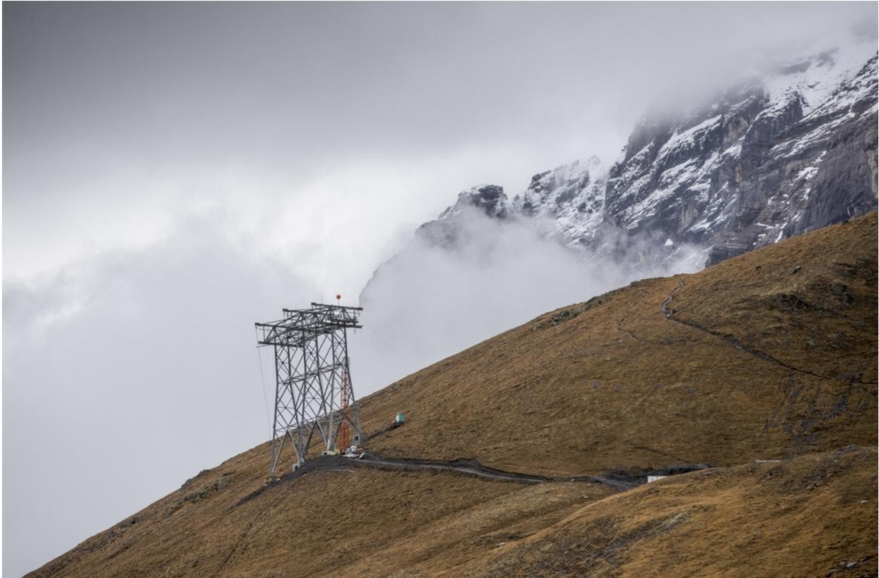
*Die Zufahrt zu Mast 7 wird teils mit Mutten begrünt, die überlebt haben, teils wird Gras neu angesät, um Erosion zu verhindern. Da auf über 2'000 Metern alles nur langsam wächst, wird es lange dauern, bis die Rekultivierung erfolgreich beendet sein wird.*
